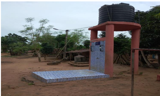
Photo 2: Vue partielle d'un PEA à Mondotokpa
